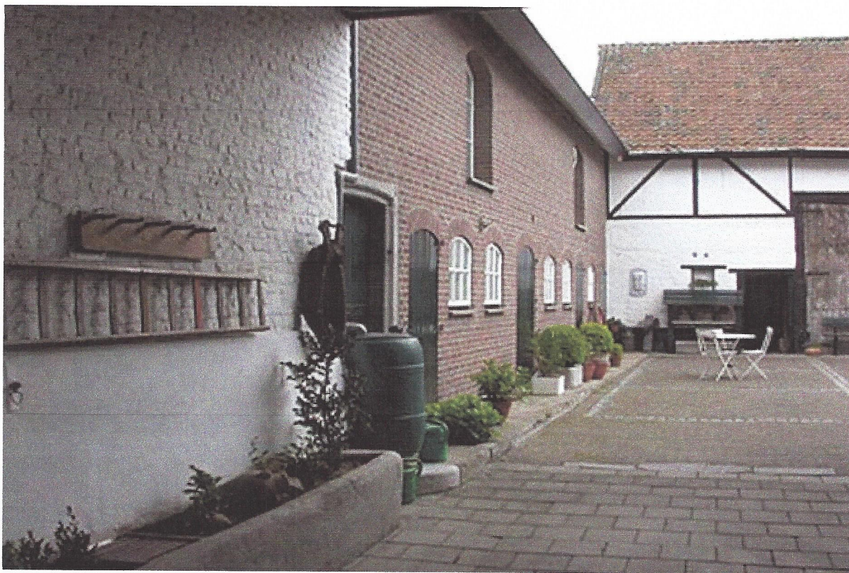
In de gevel van de voormalige koestal met hooizolder (links op de foto) zijn na de verkoop schijndeuren en - vensters aangebracht.
