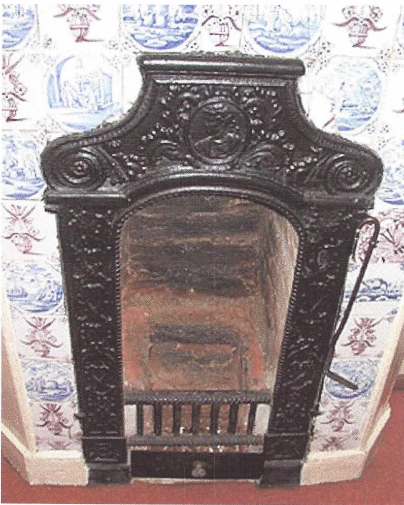
Eén van de twee schoorsteenmantels met een gietijzeren vuurmond en bekleed met tegels uit de achttiende eeuw.
